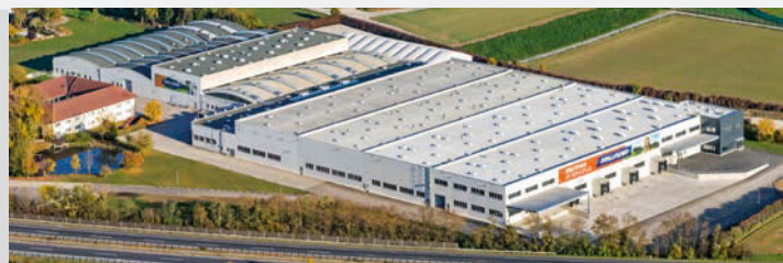
PRILLINGER-Zentrallager Wels Entrepôt central de PRILLINGER à Wels
