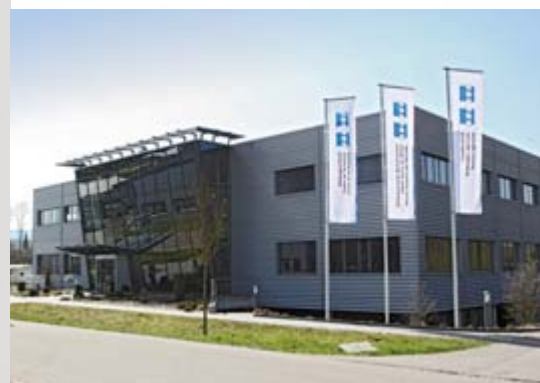
Das LMB Technik + Bildungszentrum in Weinfelden (oben) und das Bildungszentrum der Schweizerischen Metall-Union in Aarberg (unten)
