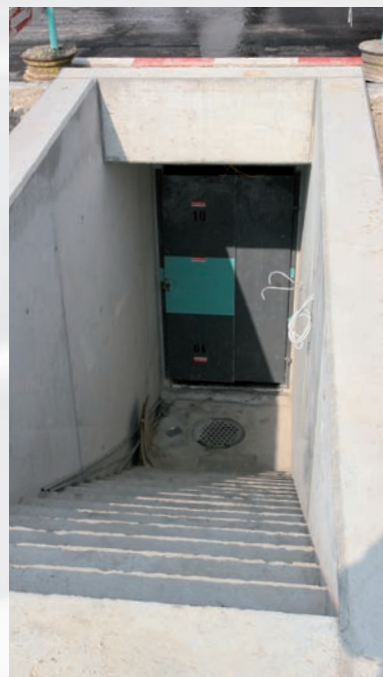
Diese Treppe wird den externen Zugang zu den erweiterten Garderobenräumen ermöglichen.
